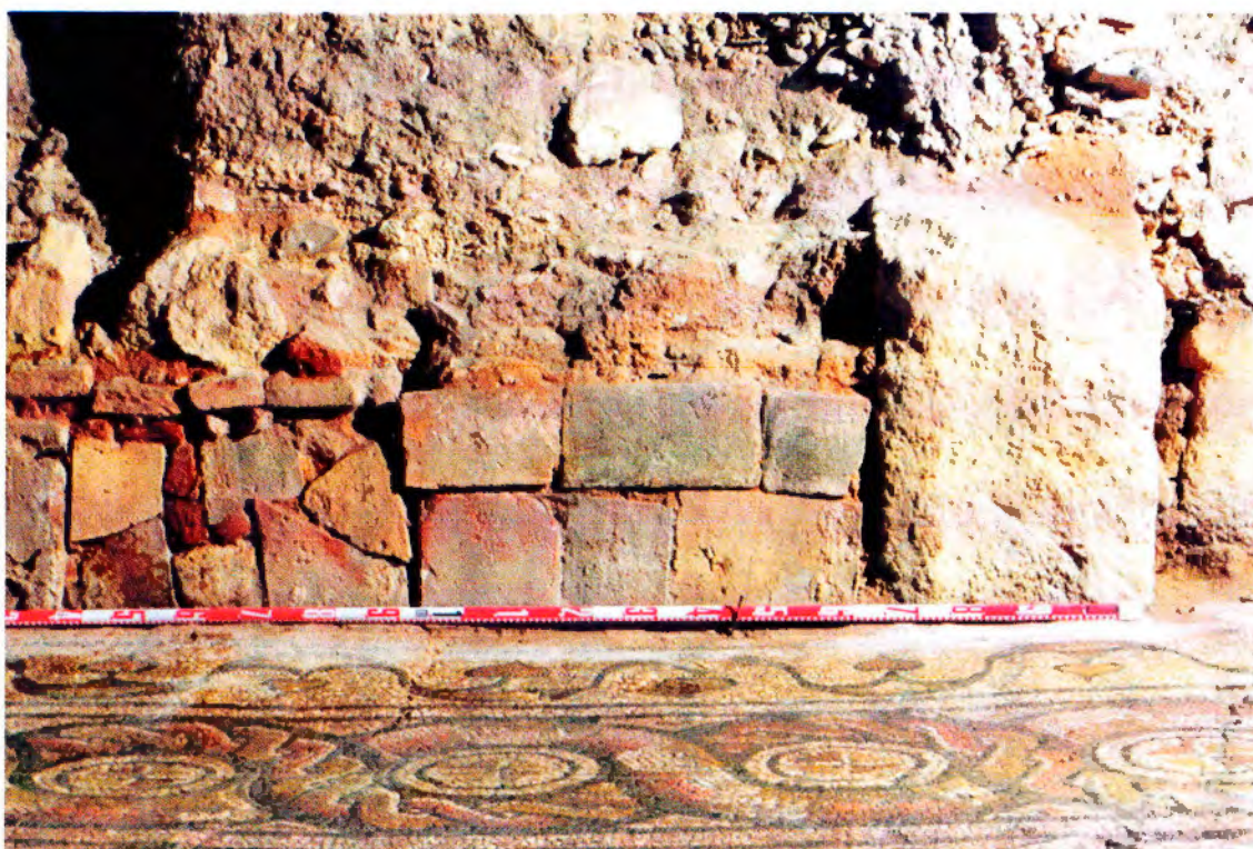
Figura 2. Pavimento musivo entregándose a estructura muraria que lo delimita al este, elaborada mediante encachado de ladrillos en plano, sillares asimétricos y alzado de tapial.
